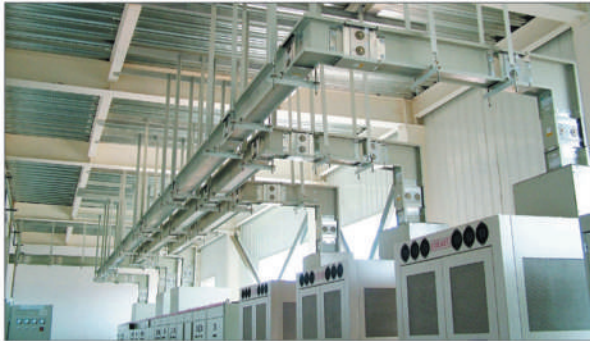
馈电式母线槽Feeder busway
